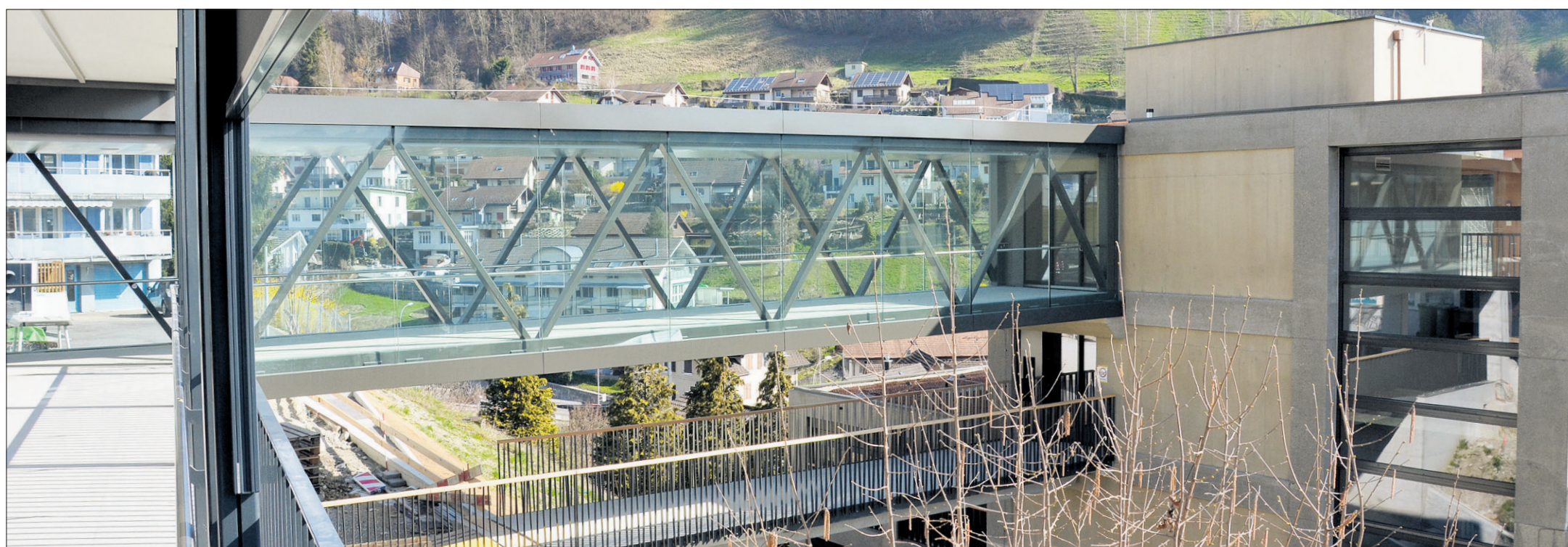
Die obere Passarelle verbindet den Neubau mit dem Wohn- und Pflegezentrum.
